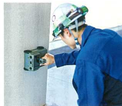
非破壊検査は、例えるなら「健康診断」。社会インフラの健康状態を診て、長寿命化に貢献する
