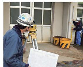
構造物沈下測定
